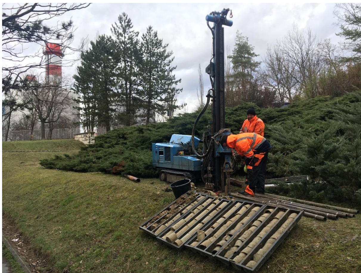
Foto č.4: Vrtné práce, sonda JV2
